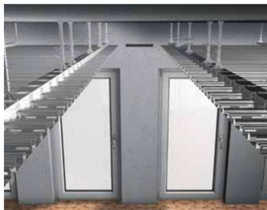
Die Kopfseiten der Klimaprofile enden rund 250 mm vor der angrenzenden Wand. Zwischen angrenzender Wand und den Kopfenden der Klimaprofile wird nach Verrohrung ein parallel zur Wand laufendes GK 1 montiert.
